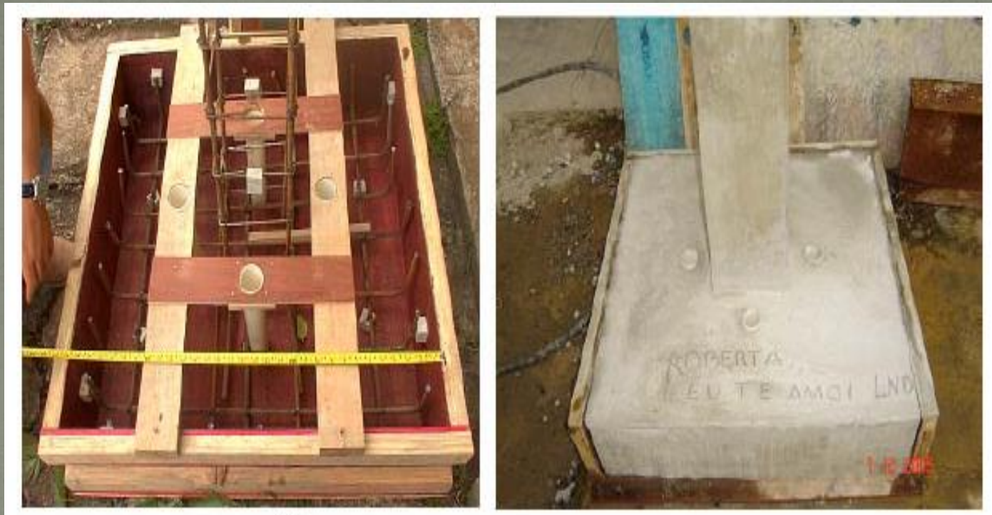
Figura 5 – Sapata pré-fabricada em concreto armado
