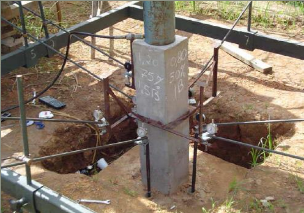
Figura 8 – Detalhe da instalação dos extensômetros
